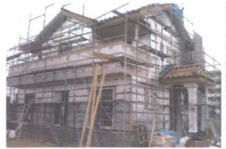
HMシートで構造躯体をすっぽり包み込む外断熱を高気密工法(在来工法上棟時気密測定  $1.88\text{cm}^2/\text{m}^2$ )で施工した住宅で、その効果をサーモカメラによって評価いたしました。
